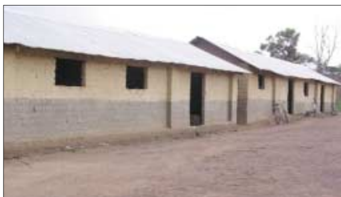
I vecchi edifici scolastici in via di ristrutturazione.
